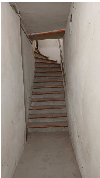
Scala ingresso cantine
